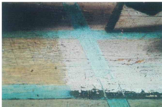
Fig. 3 Détail en cours de nettoyage montrant les déplacements des bandes blanches sur le fond rosé du carrelage et témoignant d'un projet à motifs plus resserrés. © Annie Hochart-Giacobbi.
